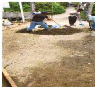
Foto 3 Sustitución de piso torta de concreto
