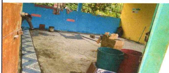
Foto 8 sustitución de piso de concreto por ceramico
