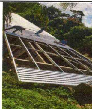
Foto 6 Sustitución de madera por costanera de metal y cubierta de lamina
