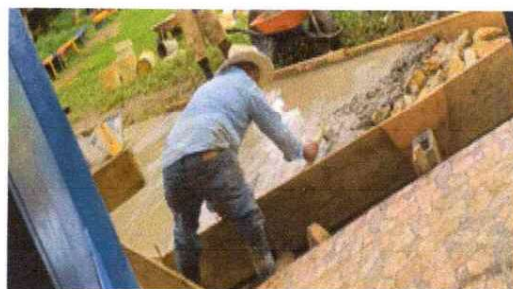
Foto 4 Sustitución de piso torta de concreto
