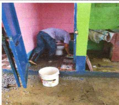
Foto 9 Sustitución de piso de concreto por piso ceramico
