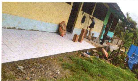
Foto 2 Sustitucion de piso torta de concreto por granito
