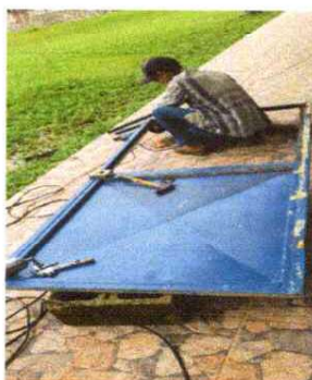
Foto 5 Sustitución de puerta de metal
