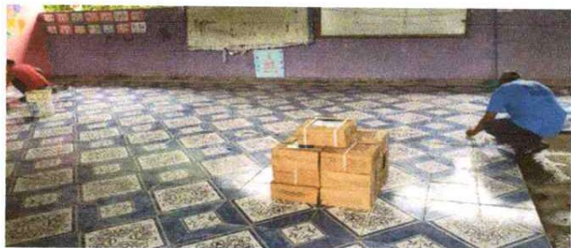
Foto 1 Aula No. 1 Sustitución de piso de torta de concreto por ceramico
