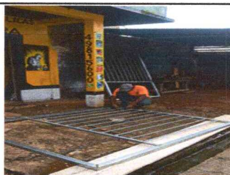
Foto 10 Sustitución de Porton
