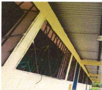
Foto 7 Mantenimiento de ventana
