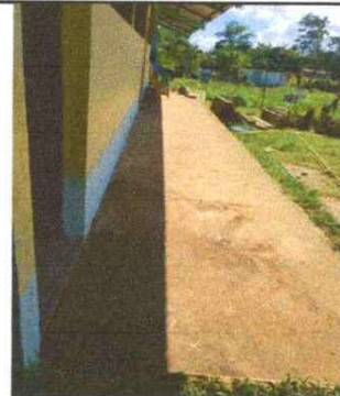
Foto 2 Sustitución de piso torta de concreto por granito
