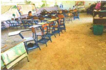
Foto 1 aula No. 1 Sustitución de piso de torta de concreto por ceramico
