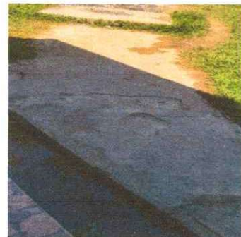
Foto 4 Sustitución de piso torta de concreto
