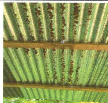
Foto 6 Sustitución de madera por costaneras de metal y cubierta de lámina
