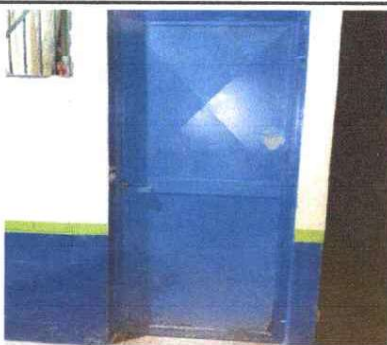
Foto 5 Sustitución de puerta de metal
