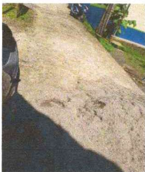
Foto 3 Sustitución de piso torta de concreto
