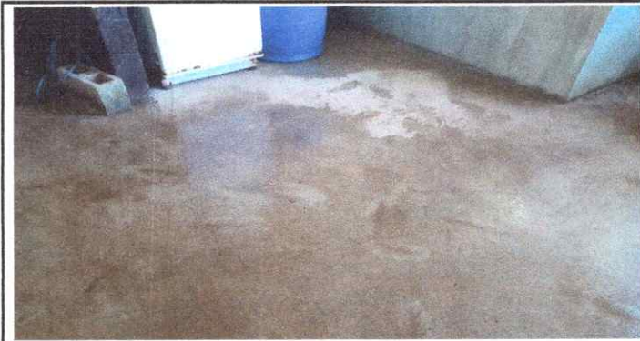
FOTO 3: Sustitución de piso de cemento liquido
