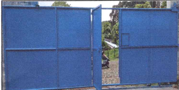
FOTO 6: Mantenimiento de Portón (lijado, cambio de tubo, cepillado, sujeciones, aplicación de pintura)
