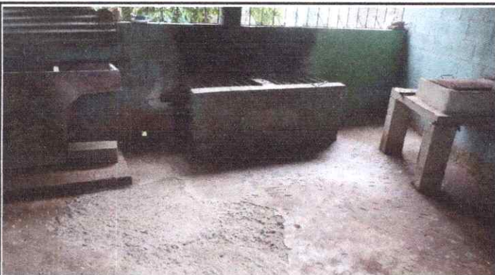
FOTO 3: Sustitución de piso de cemento líquido
