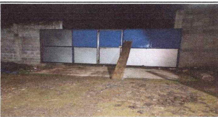
FOTO 6: Mantenimiento de Portón (lijado, cambio de tubo, cepillado, sujeciones, aplicación de pintura)
