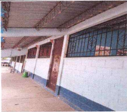
Sustitucion de balcones de metal.
