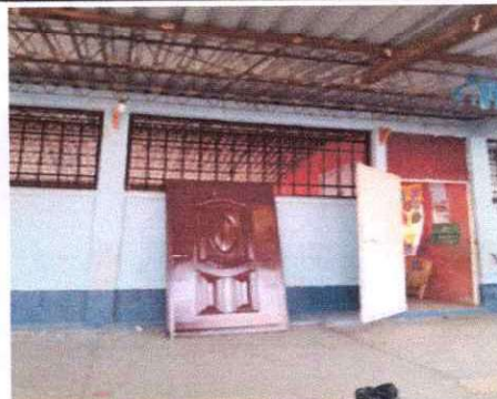
Sustitución de puerta
