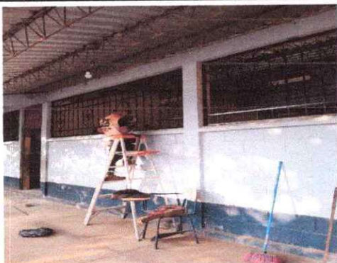
Sustitucion de balcones de metal.
