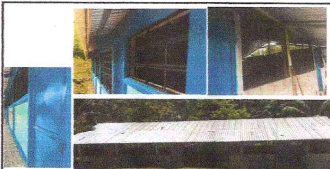
Puertas y ventanas finalizadas
