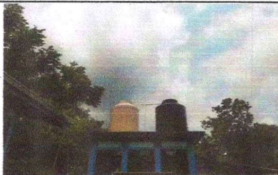
Deposito de agua finalizado
