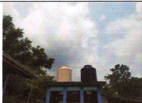
Sustitución de depositos de agua
