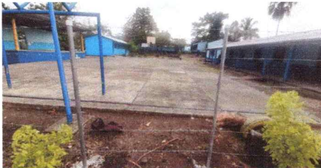
* Reparación de cerco de alambre de púa.
