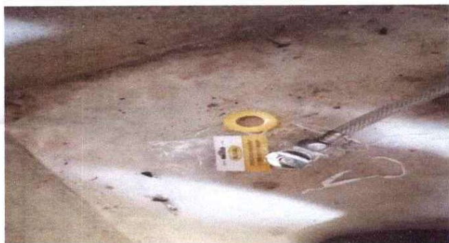
* Sustitución de llave de paso.
