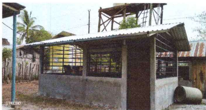
Fotografía 1: Sustitución de lámina, por lámina troquelada aluzin calibre 26, sustitución de puerta.
