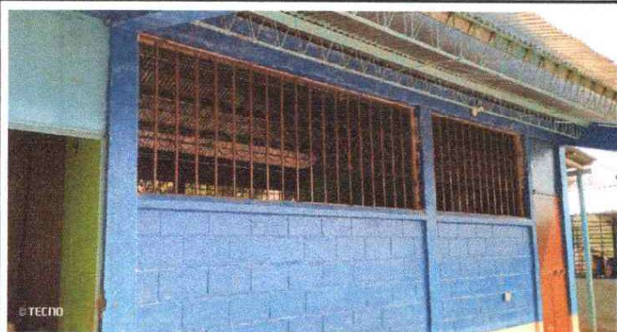
Fotografía 3: Sustitución de estructura de metal de ventana.
