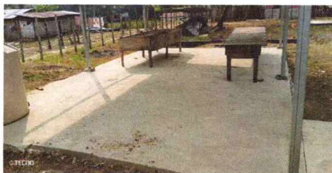
Fotografía 2: Reparación de Piso de torta de concreto.
