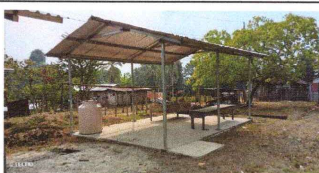
Fotografía 4: Estructura de Techo.
