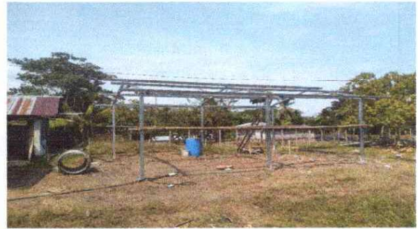
Fotografía 4: Estructura de Techo.
