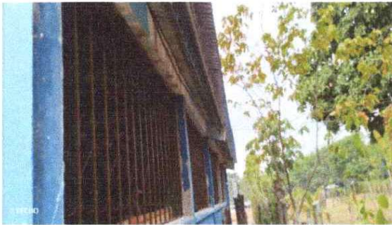
Fotografía 3: Sustitución de estructura de metal de ventana.
