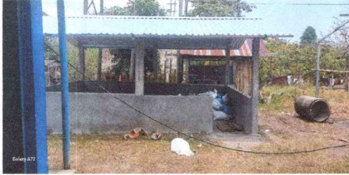
Fotografía 1: Sustitución de lámina, por lámina troquelada aluzin calibre 26, sustitución de puerta.
