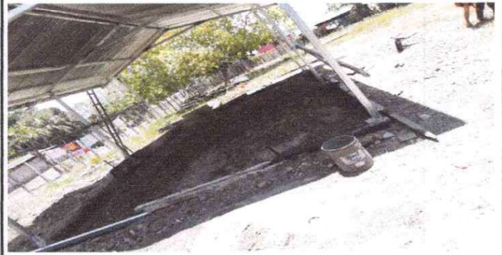
Fotografía 2: Reparación de Piso de torta de concreto.
