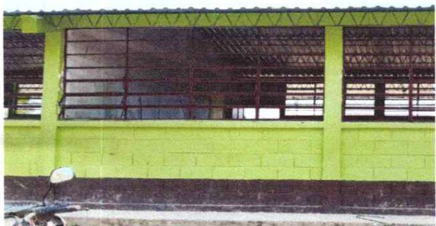
Colocacion de los vidrios de las ventanas de la Escuela
