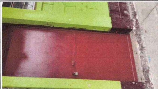
Puertas nuevas para las aulas
