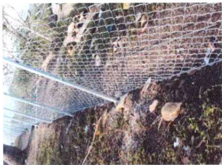
Colocación de malla alrededor del centro educativo
