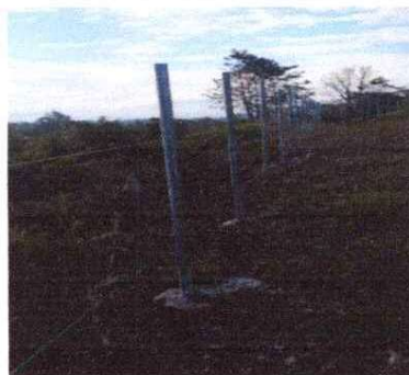
colocación de postes de metal donde ira la malla
