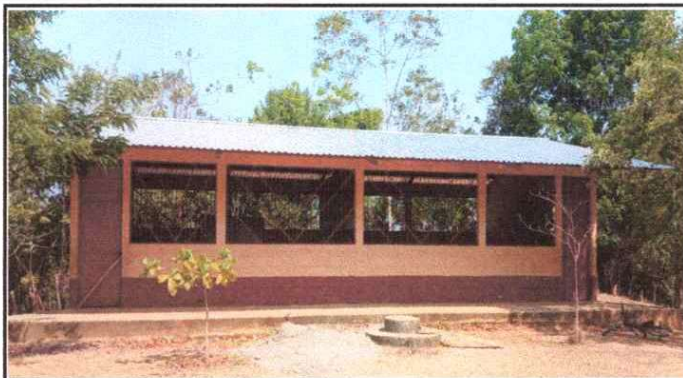
Foto 2: Sustitución de láminas, por láminas troqueladas.
