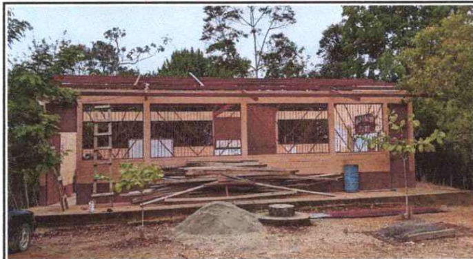
Foto 2: Sustitución de láminas, por láminas troqueladas.
