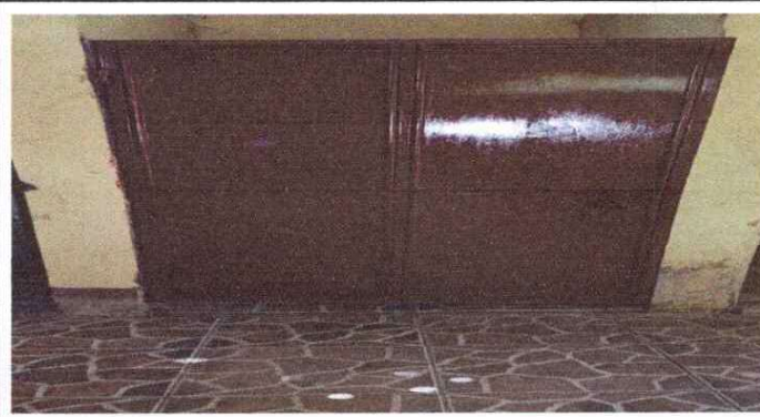
FOTO 2: Reparación de Puertas
