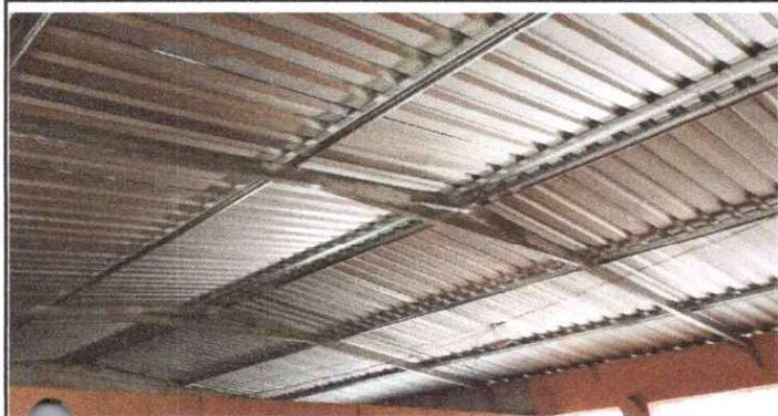
FOTO 1: cubierta de lamina y estructura de techo.
