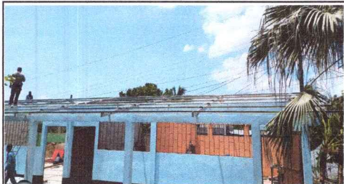
FOTO 1: cubierta de lamina y estructura de techo.
