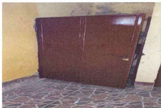
FOTO 2: Reparación de Puertas
