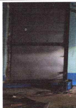
FOTO 2: Sustitución de puerta
