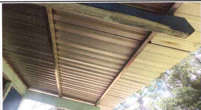
3. ESTRUCTURA METALICA INSTALADA
