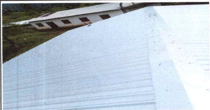
1. LAMINA DE TROQUELADA CALIBRE 26 INSTALADA
