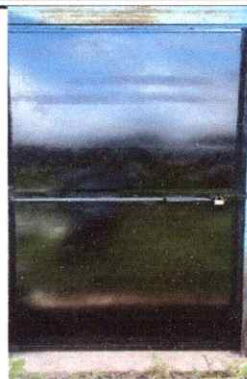
2. PUERTA METALICA INSTALDA
