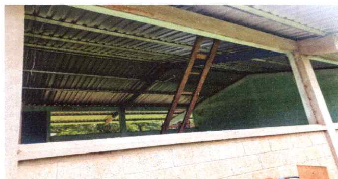
4. INSTALACIÓN DE BALCONES
