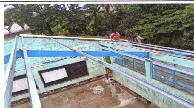
3. INSTALACIÓN DE ESTRUCTURA METALICA
