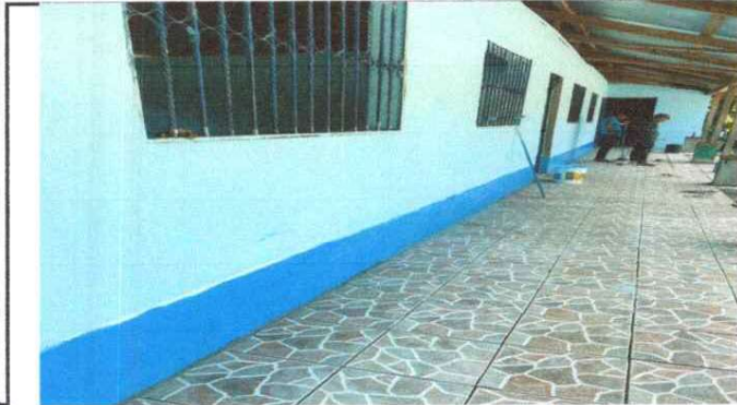
FOTOGRAFIA 1: Sustrucion de piso
