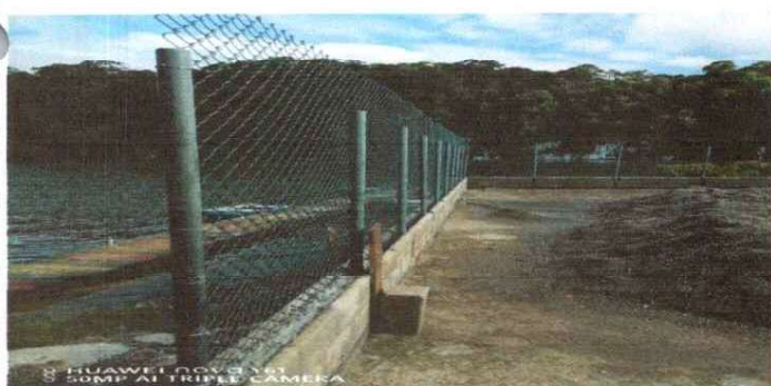
Fotografía 5: Mantenimiento de Muro Perimetral
