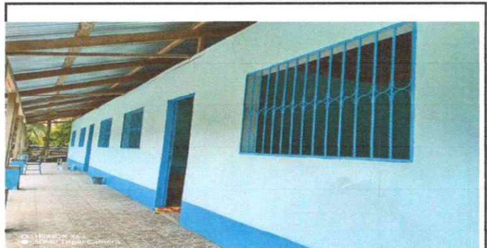
Fotografía 4: Mantenimiento de balcones
