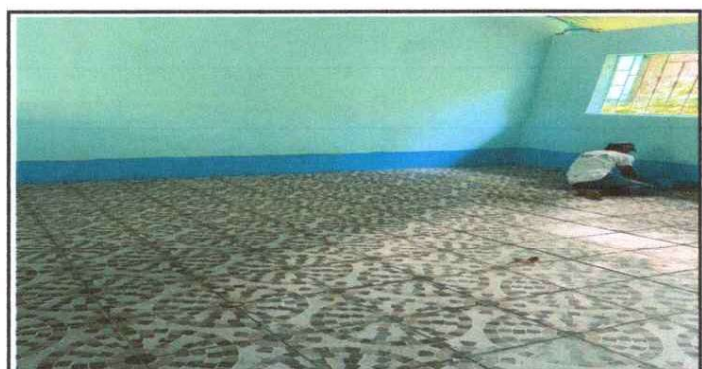
Fotografía 6: Mantenimiento de pintura
