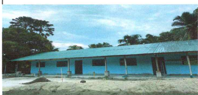
Fotografia 6: Mantenimiento de pintura
