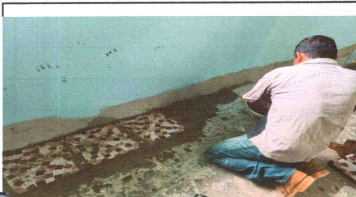
FOTOGRAFIA 1: Sustitucion de piso
