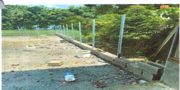
Fotografia 5: Mantenimiento de Muro Perimetral
