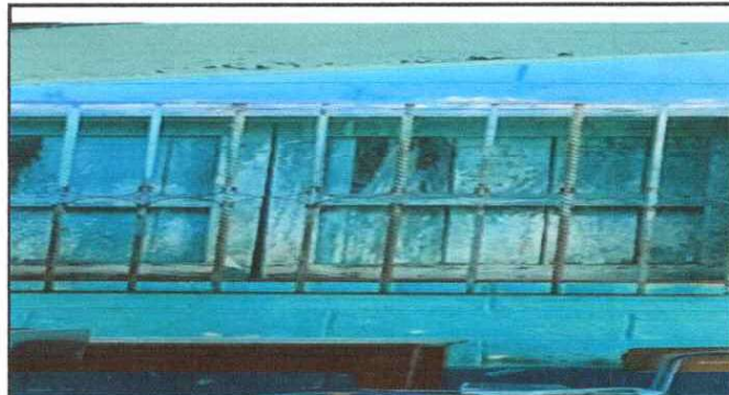
Fotografia 4: Mantenimiento de balcones
