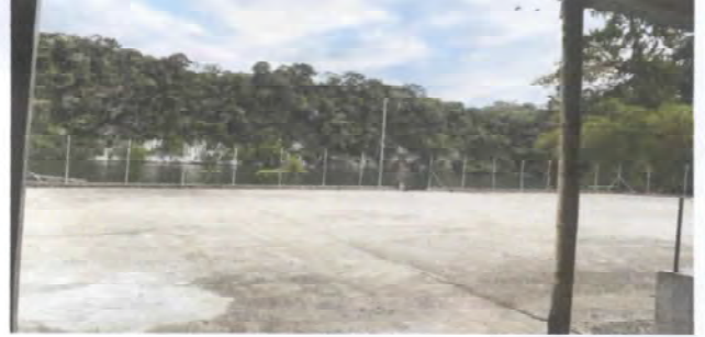
FOTOGRAFIA 8: Mantenimiento de muro perimetral
