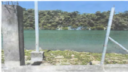
FOTOGRAFIA 9: Mantenimiento de muro perimetral
