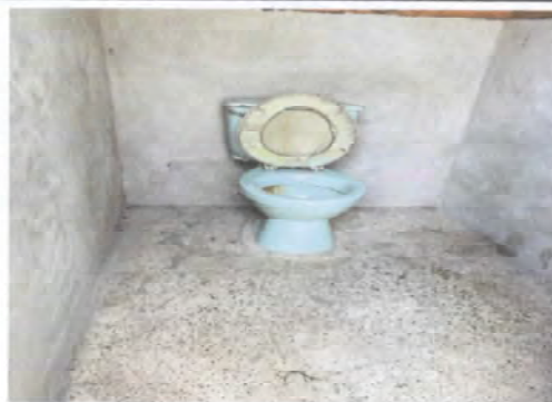
FOTOGRAFIA 4: Sustrucion de baño.
