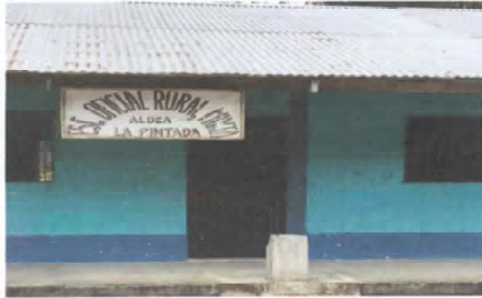
FOTOGRAFIA 7: Mantenimiento de puertas
