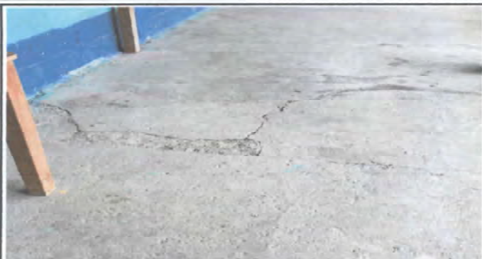
FOTOGRAFIA 1: Sustrucion de piso en el aula
