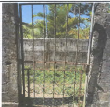
FOTOGRAFIA 5: Mantenimiento de porton.
