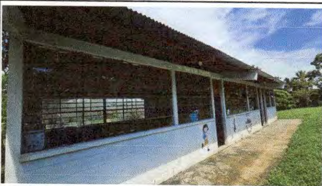
Foto 3: REMOZAMIENTO DE TECHO EN AULAS
