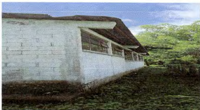
Foto 6: .REMOZAMIENTO DE TECHO DE LAMINA
