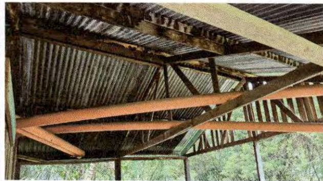
Foto 7: REMOZAMIENTO DE ESTRUCTURA METALICA
