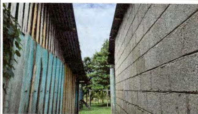
Foto 10: REMOZAMIENTO DE LAMINA
