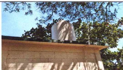
Sustitución de depósito de agua
