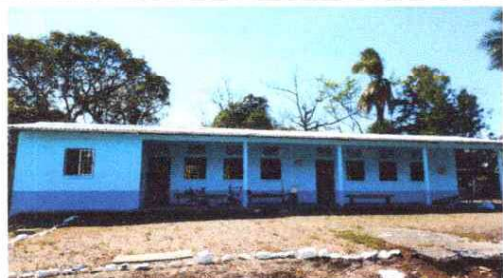
Sustitución de lámina troquelada aluzinc calibre 26
