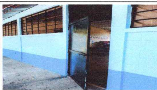
Mantenimiento a estructura ( lijado, cepillado, sujecione, aplicación de pintura.
