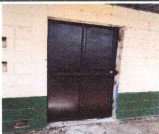
sustitución de puertas.
