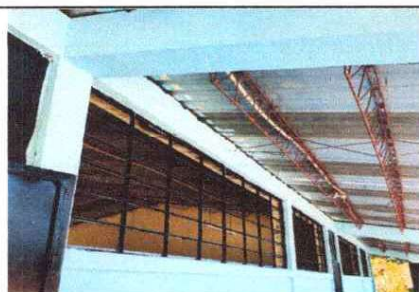
Mantenimiento a balcones de metal.
