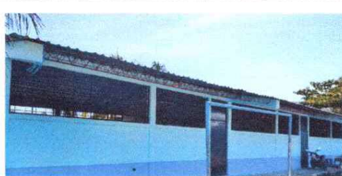
Mantenimiento a estructura de soporte de metal.
