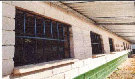
Sustitucion de balcones de metal.
