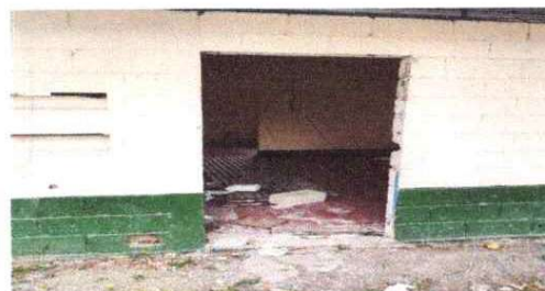
sustitución de puertas.
