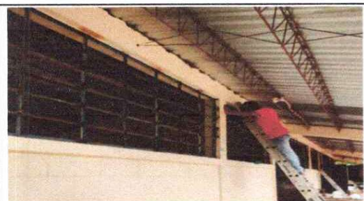
Mantenimiento a balcones de metal.
