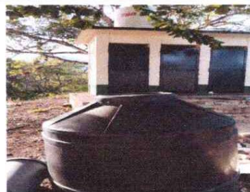
Sustitución de depósito de agua
