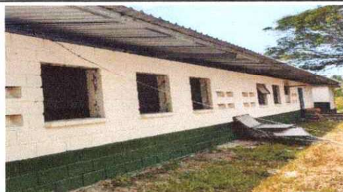
Sustitucion de balcones de metal.
