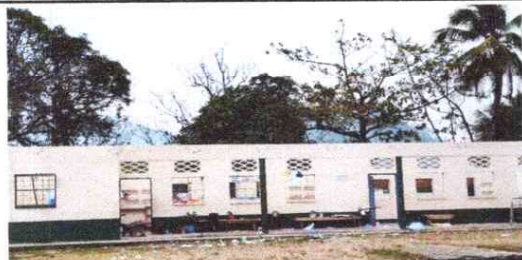
Sustitución de lámina troquelada aluzinc calibre 26
