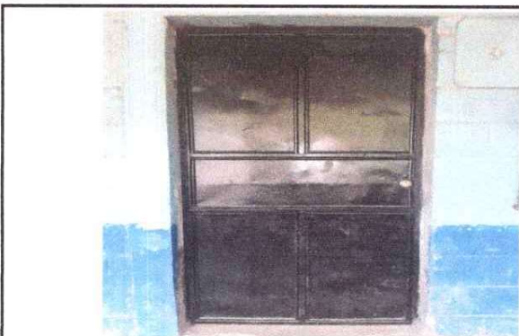
FOTO 3: Mantenimiento a estructura (lija, cambio de tubo, cepillado, sujeciones, aplicaciones de pintura)
