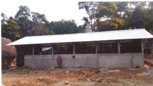
1.1 Sustitución de lámina, por lamina troquelada calibre 26
