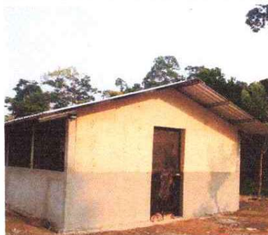
4.3 Sustitución de puerta de madera por metal
