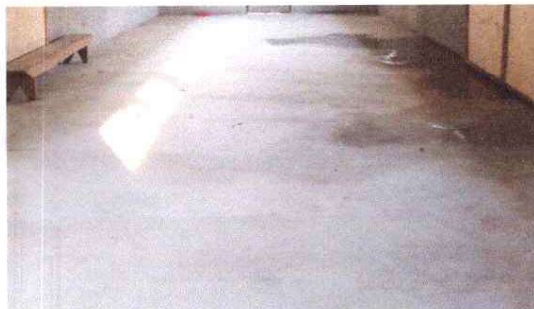
6.5 Sustitución de piso de torta de concreto por piso de cemento liquido
