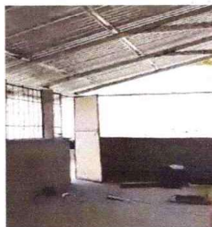
4.3 Sustitución de puerta de madera por metal
