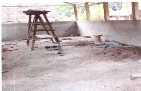
6.5 Sustitución de piso de torta de concreto por piso de cemento líquido
