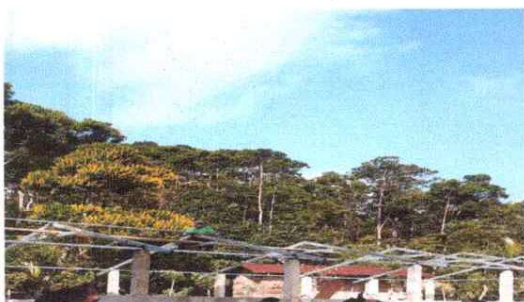
1.1 Sustitución de lámina, por lamina troquelada calibre 26
