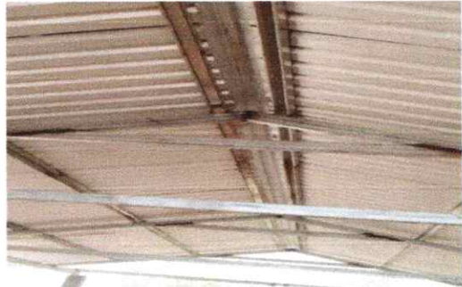
Foto 2: ESTRUCTURA DE SOPORTE DE METAL INSTALADO
