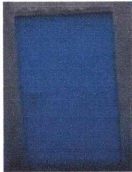
Foto 3: PUERTA DE METAL INSTALADO
