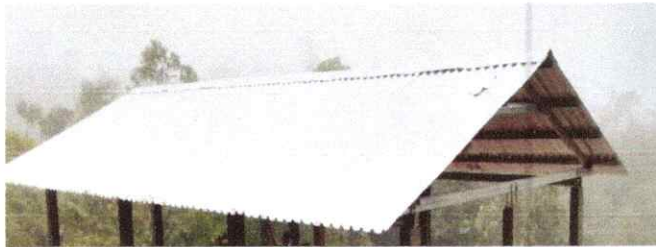
Foto 1: LAMINA TROQUELADA CALIBRE 26 INSTALADA
