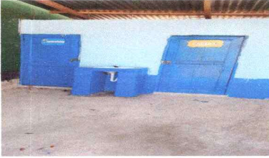
COLOCACION DE LAVAMANO
