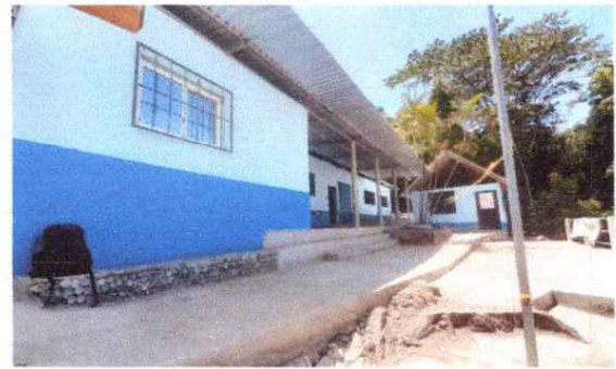
colocacion de pintura
