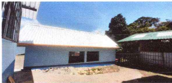
colocacion de tubo como canal
