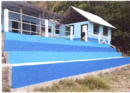
MURO DE CONTENCION
