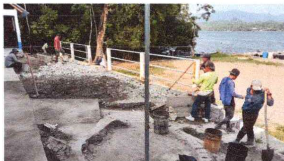
mantenimiento de barandas de a metal y patio delantero
