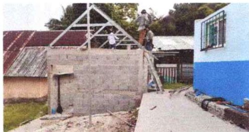
sustitucion de lamina
