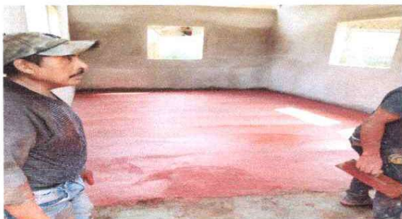
sustitucion de piso en aula.
