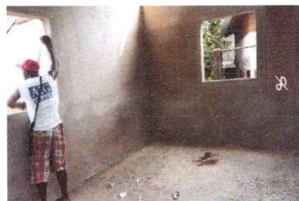
sustitucion por balcones
