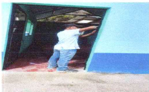
sustitucion de puerta
