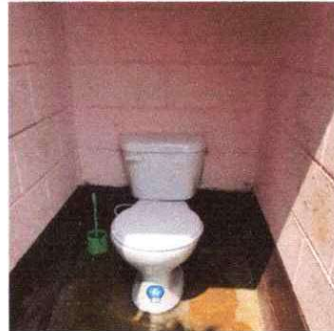
foto 4 finalización de reparación de baño
