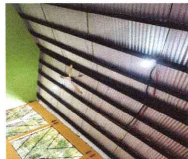
FOTO 6 FINALIZACIÓN DE CABLEADO ELÉCTRICO
