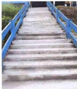
foto 3 finalización de reparación de gradas
