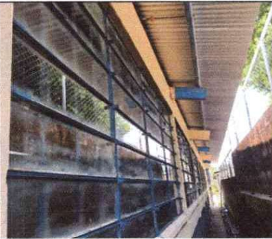
FOTO 1 FINALIZACIÓN DE SUSTITUCIÓN DE VIDRIO Y MANTENIMIENTO DE ESTRUCTURA METALICA.
