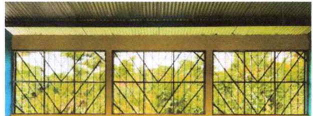
FOTO 2 FINALIZACIÓN DE MANTENIMIENTO Y ESTRUCTURA METALICA
