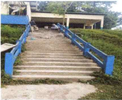
FOTO 3 PROCESO DE REPARACIÓN DE GRADAS
