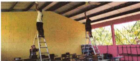
Foto 5: PROCESO DE SUSTITUCIÓN DE LAMPARA LED
