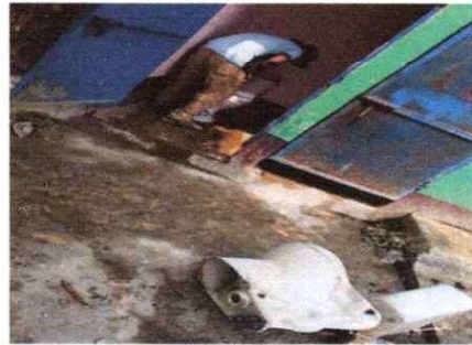
FOTO 4: PROCESO DE SUSTITUCIÓN DE BAÑO
