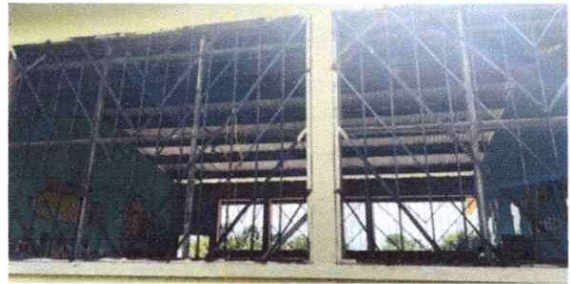
FOTO 2 PROCESO DE MANTENIMIENTO ESTRUCTURA METALICA
