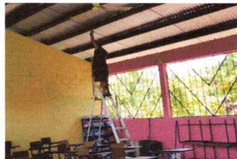
Foto 6: PROCESO SUSTITUCIÓN DE CABLEADO ELECTRICO
