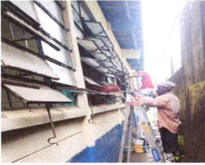
FOTO 1 PROCESO DE SUSTITUCIÓN DE VIDRIO
