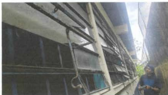
FOTO 1: SUSTITUCIÓN DE VIDRIO Y MANTENIMIENTO DE ESTRUCTURA DE METAL DE VENTANA
