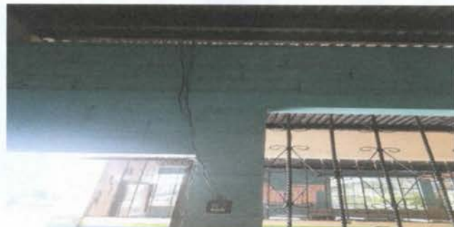
FOTO 6: REPARACIÓN DE CABLEADO ELECTRICO.
