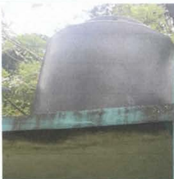
FOTO 3: SUSTITUCIÓN DE DEPÓSITO DE AGUA 1100 lt
