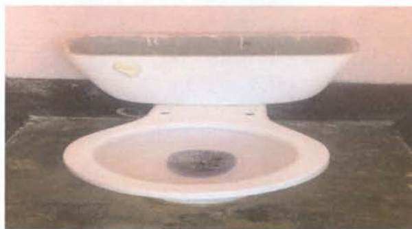
FOTO 4: SUSTITUCIÓN DE INODORO
