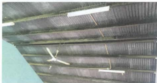
FOTO 5: SUSTITUCIÓN DE LAMPARAS TIPO LED
