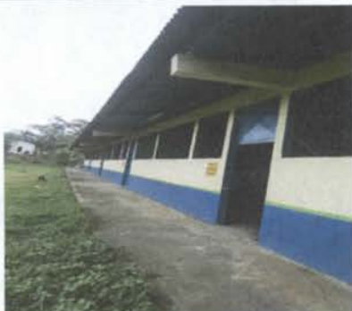
FOTO 7: SUSTITUCIÓN DE PISO CONCRETO POR PISO GRANITO
