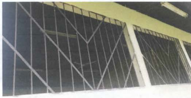
FOTO 2: MANTENIMIENTO A ESTRUCTURA DE METAL DE VENTANA
