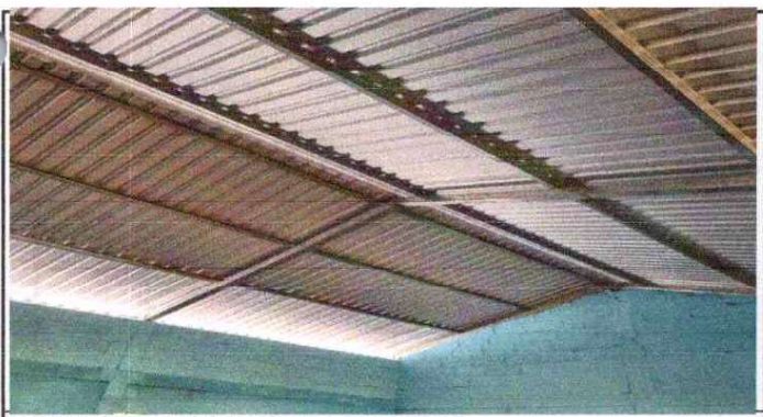
SUSTITUCION DE ESTRUCTURA DEL TECHO
