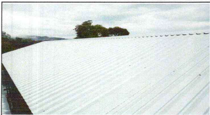
SUSTITUCION DE TECHO
