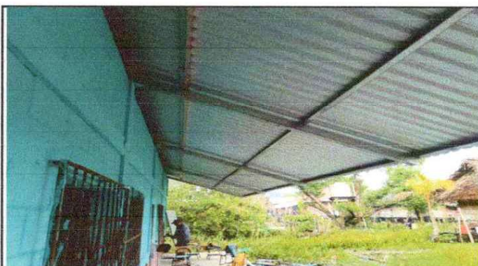
LEVANTADO DE BLOCK EN LA PARTE SUPERIOR DE LAS AULAS
