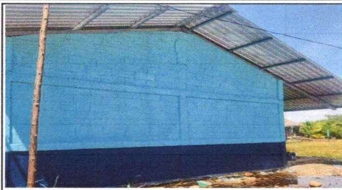
CAMBIO DE PINTURA EXTERIOR DE LAS AULAS
