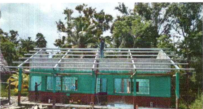
SUSTITUCION DE ESTRUCTURA DEL TECHO
