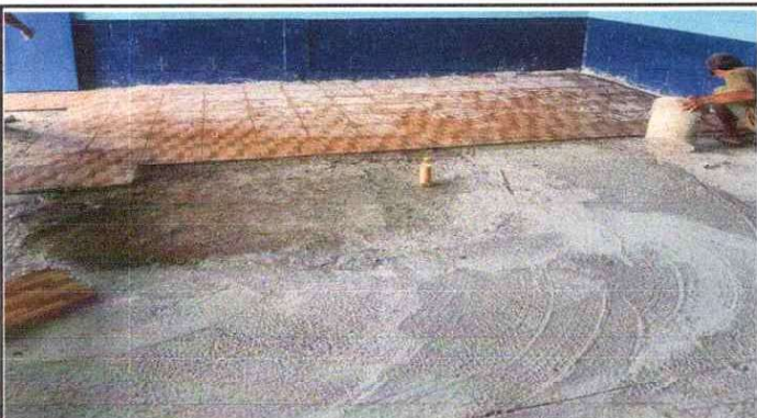
SUSTITUCIÓN DE PISO Y PINTURA INTERIO DE AULA
