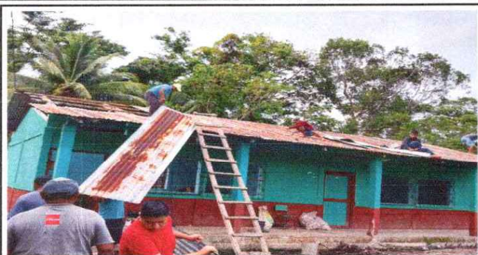
SUSTITUCION DE TECHO
