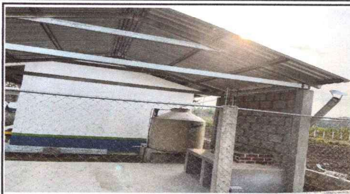
FOTO 2: Sustrucción de estructura de madera, por metal.
