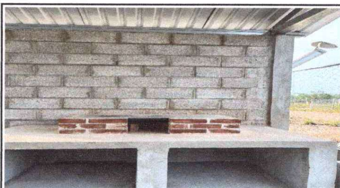
FOTO 4: Sustrucción de Estufa Rural completa.
