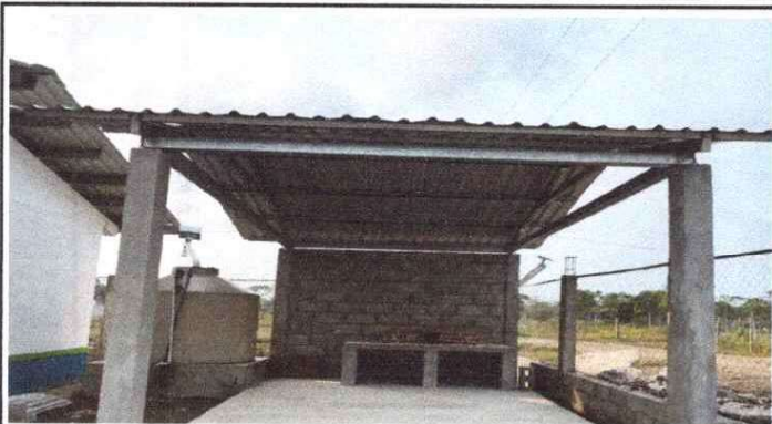
FOTO 1: Sustrucción de lámina por lámina troquelada calibre 26 aluzinc.
