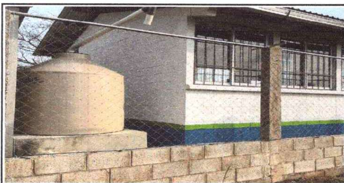
FOTO 5: Reparación de Muro perimetral con block con tubo hg y malla galvanizada, soleras intermedias y columnas.
