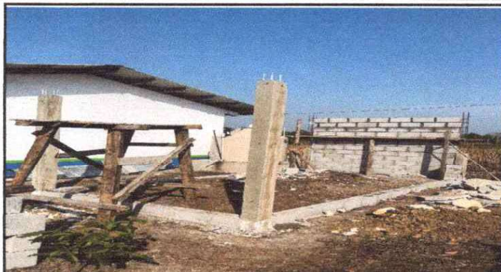
FOTO 2: Sustitución de estructura de madera, por metal.
