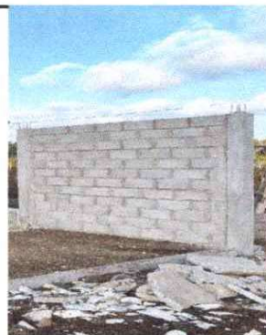
FOTO 4: Sustitución de Estufa Rural completa.
