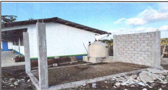
FOTO 3: Sustitución de Piso
