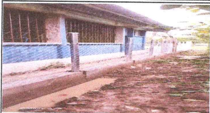
FOTO 1: Reparación de muro perimetral de block con tubo hg y malla organizada, soleras intermedias.
