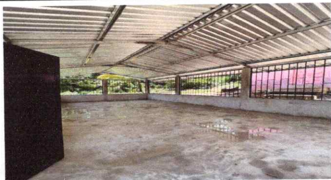
4. PISO DE TORTA DE CONCRETO
