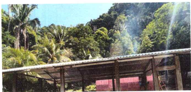
1. INSTALACIÓN DE LAMINAS TROQUELADA CALIBRE 26
