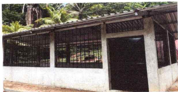
3. PUERTA METALICA INSTALADA
