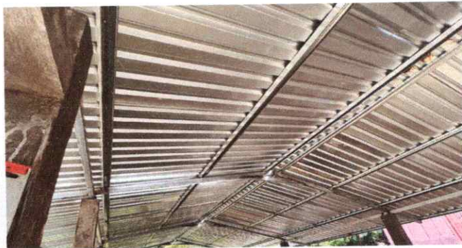
2. ESTRUCTURA METALICA INSTALADA
