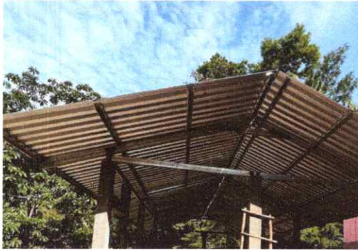
1. INSTALACIÓN DE LAMINAS POR LAMINA TROQUELADA
