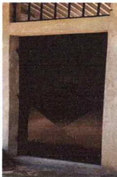
3. INSTALACIÓN DE PUERTA METALICA
