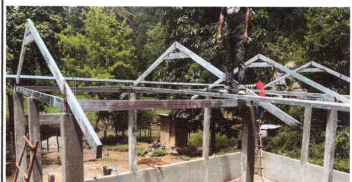
2. INSTALACIÓN DE ESTRUCTURA METALICA
