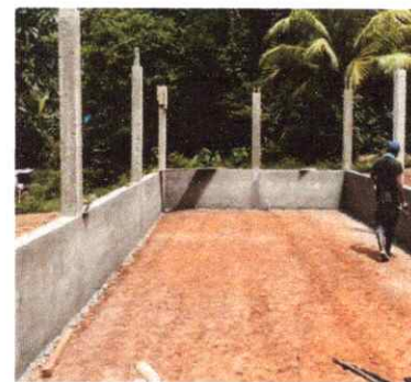
4. SUSTITUCIÓN DE PISO
