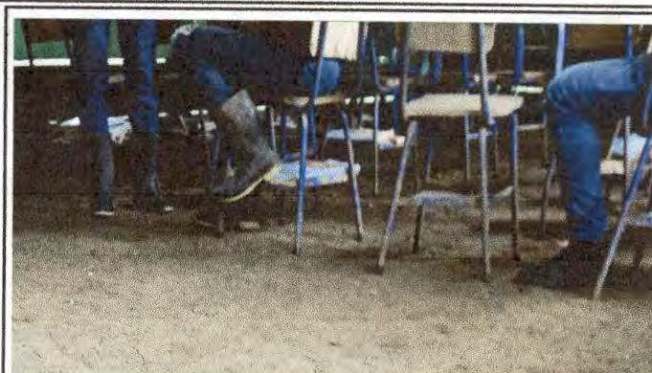
Foto 8: REMOZAMIENTO PISO, SUMINIISTRO E INSTALACION DE PISO CERAMICO ANTIDESLISANTE.
