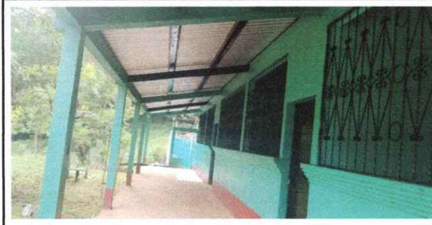
Foto 2: Pintada de corredor y Balcones
