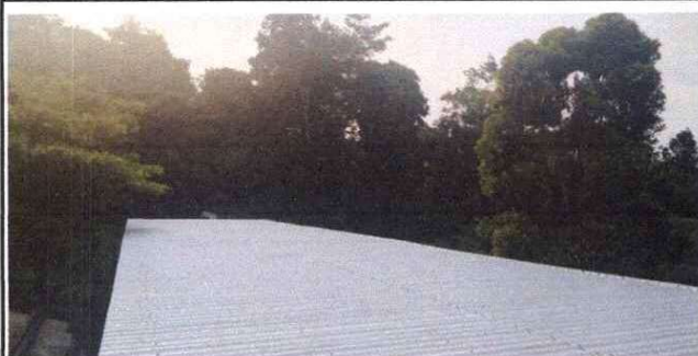
Foto 1: Cambio de Techado del Instituto
