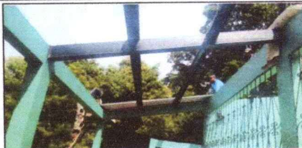
Cambio de techo del Instituto
