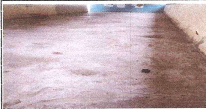
FOTO 4: Sustitución de Torta de Cemento.
