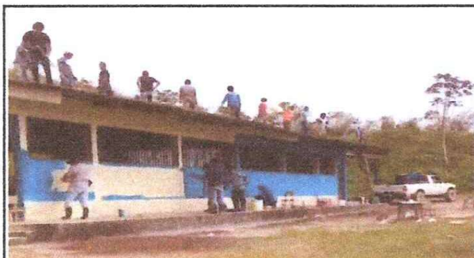
FOTO 3: Pintura en muros exteriores e interiores
