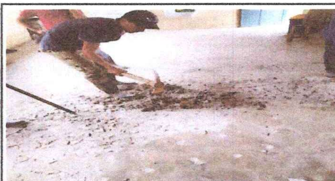
FOTO 4: Sustitución de Torta de Cemento.
