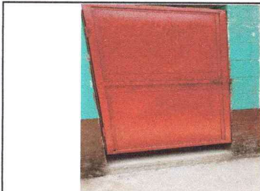
FOTO 1: SUSTITUCIÓN DE PUERTA DE MADERA POR METAL
