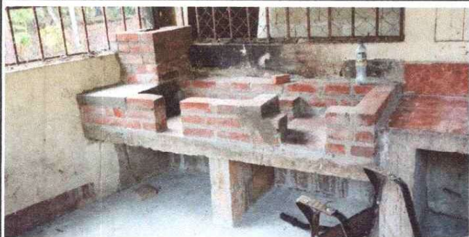
FOTO 5: Sustitución de Estufa Rural (completa) incluye chimenea y plancha de metal
