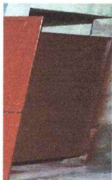
FOTO 1: SUSTITUCIÓN DE PUERTA DE MADERA POR METAL
