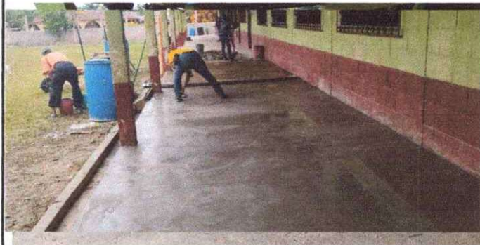
FOTO 2: Reparación de piso de torta de concreto
