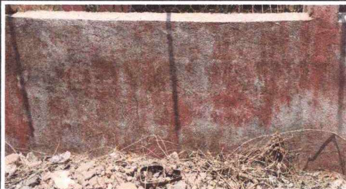
FOTO 4: Pintura en muros exteriores e interiores
