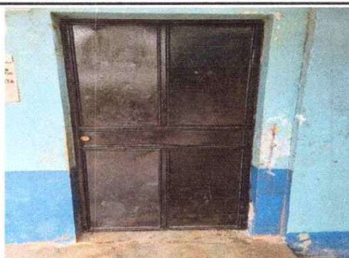
FOTO 2: Mantenimiento a estructura (lija, cambio de tubo, cepillado, sujeciones, aplicaciones de pintura)
