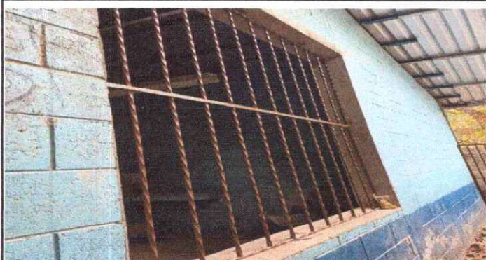
FOTO 3: Sustitución de ventana de metal de ventana.
