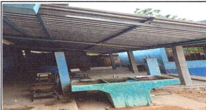
FOTO 1: CUBIERTA DE LAMINA, ESTRUCTURA DE TECHO Y SUSTITUCION DE PISO DE CONCRETO.
